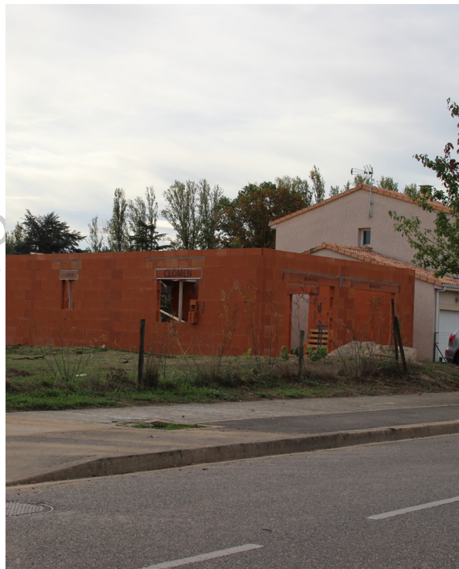
Maison individuelle en cours de construction © Karthéo 2022
