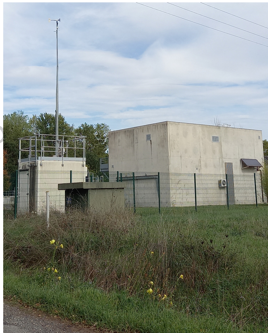
Station d'épuration © Karthéo 2022
