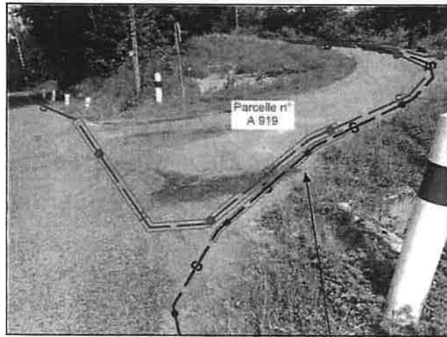
Passage sur busage en sous profondeur prévoir plaque de protection mécanique
