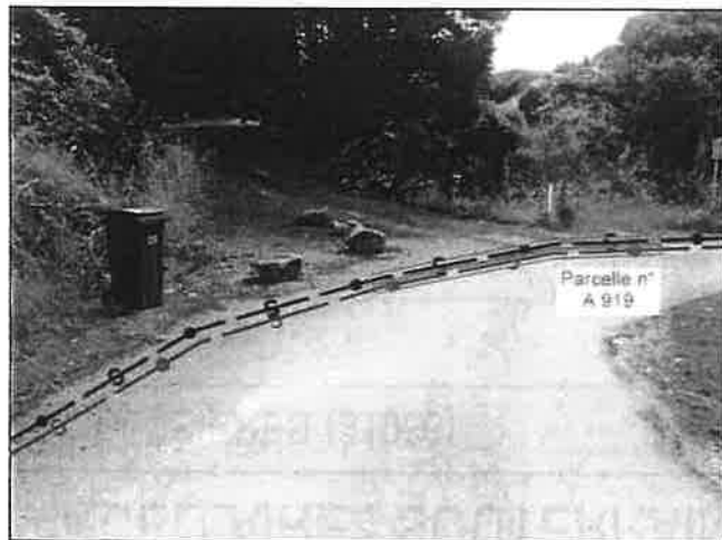
Passage sur busage en sous profondeur prévoir plaque de protection mécanique
