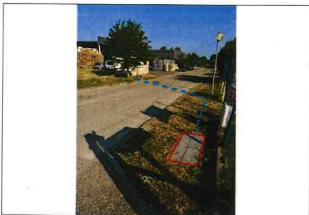
Percution Ch Orange existante, Pose de 3 PVC Ø42/45 en tranchée traditionnelle en terrain naturel Pose de 3 PVC Ø42/45 en tranchée traditionnelle sous chaussée
